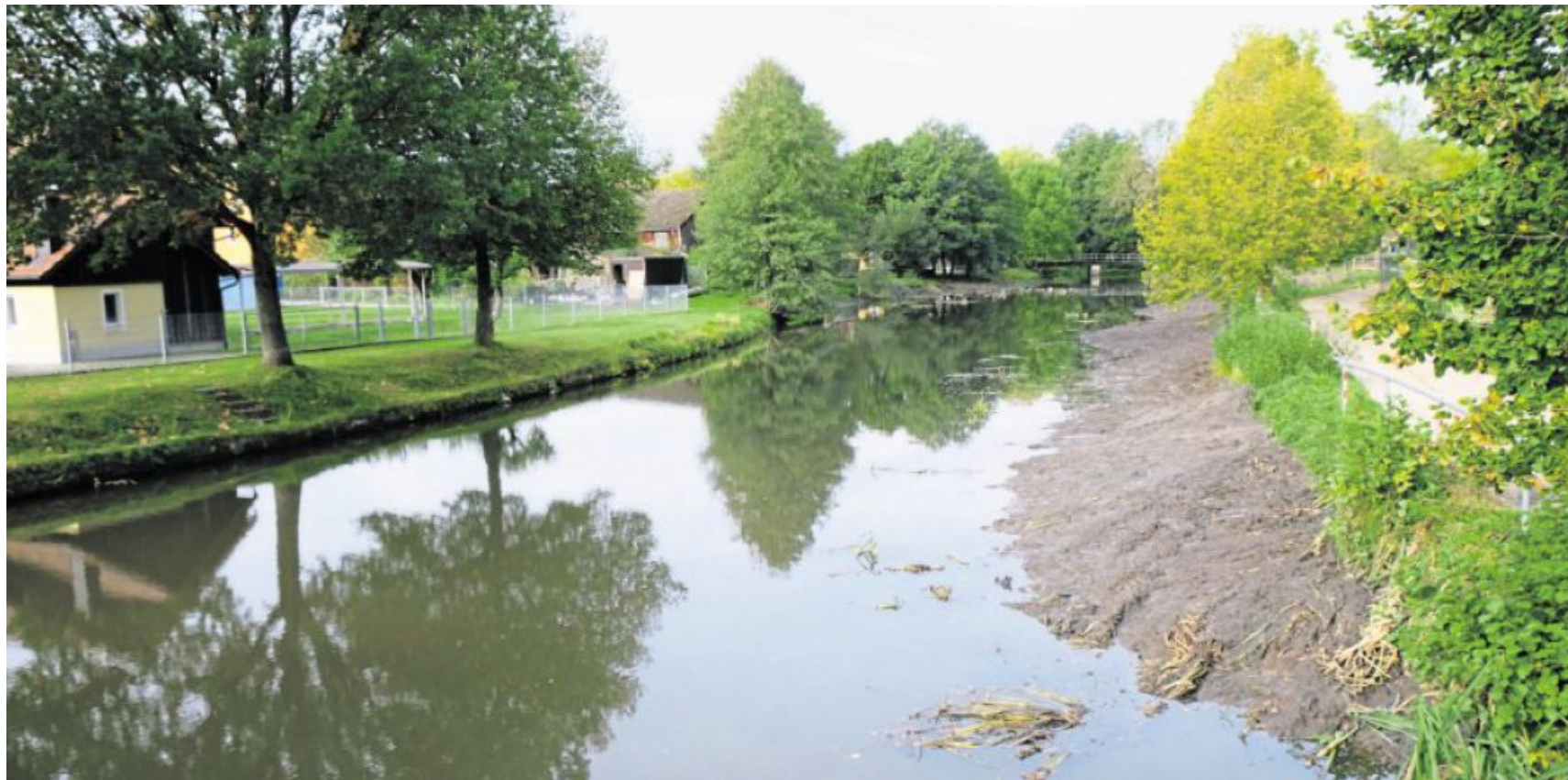
Auf Höhe Tremmersdorf haben Entlandungsmaßnahmen in der Creußen begonnen. Der Schlamm ist am Flussrand zwischengelagert.
