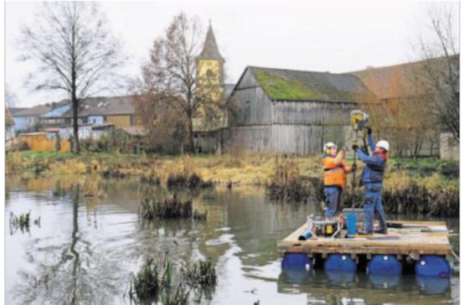
Mit einer schwimmenden Plattform mitten im Flussbett schafft der Bohrtrupp die Voraussetzung, bis zu sechs Meter tiefe Kernbohrungen mit einem Durchmesser von circa acht Zentimetern niederzubringen.
